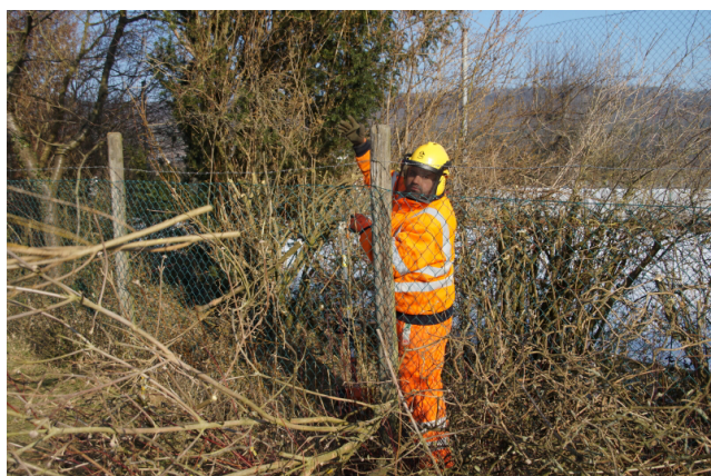
Die Bauhofmitarbeiter waren großartig!
